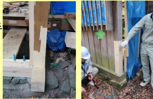
○ 金輪継手 ○ 隠金輪継手
