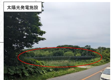
太陽光発電施設
