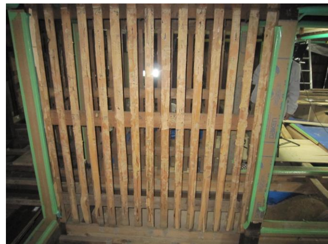
写真2 和紙仕上げの壁の縦下地状況
