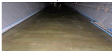
コンクリートで防護
