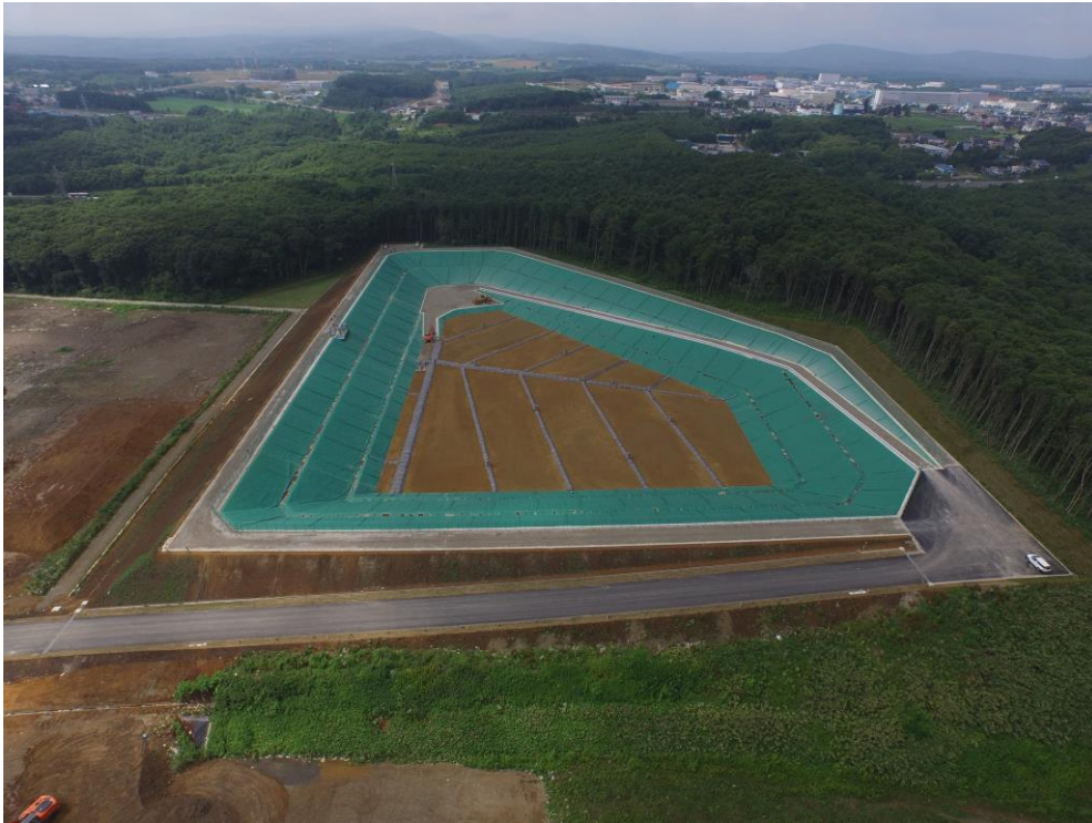
第6期最終処分場 完成時(平成27年)
