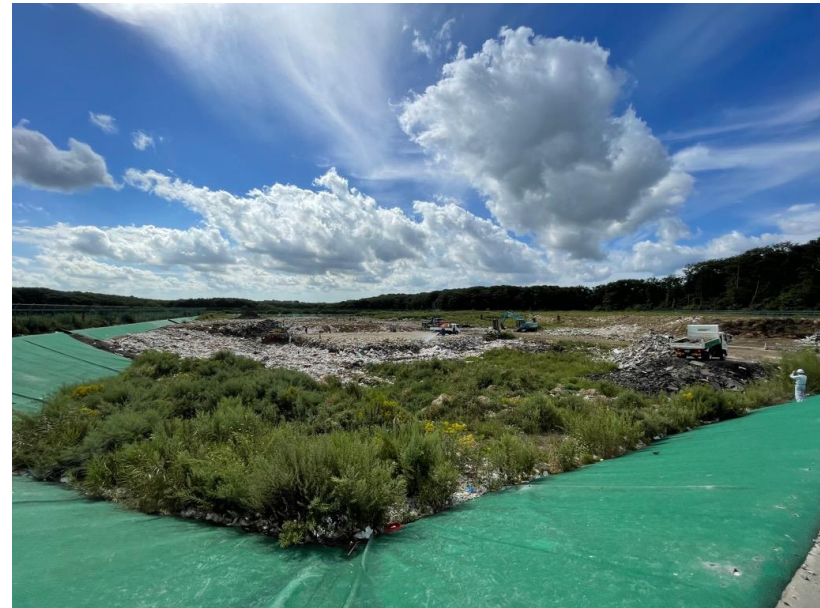
第6期最終処分場 現在(令和4年)
