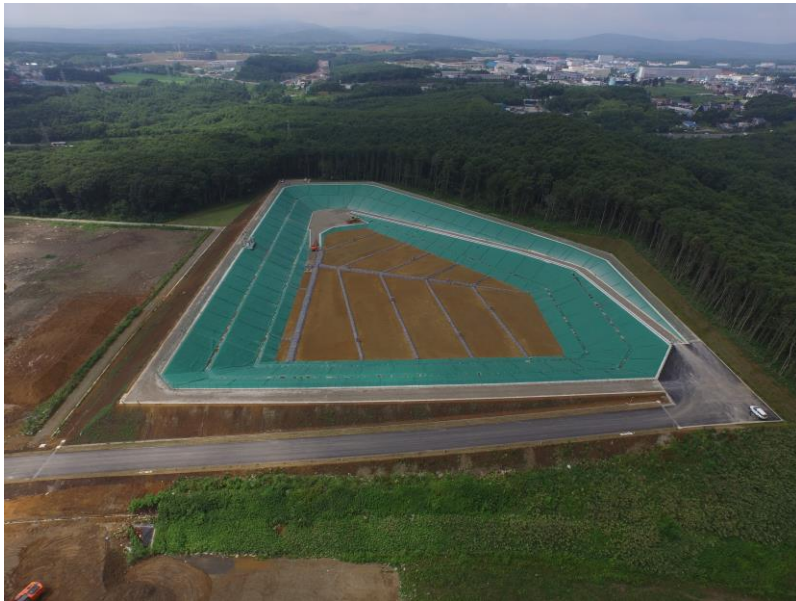
第6期最終処分場 完成時(平成27年)
