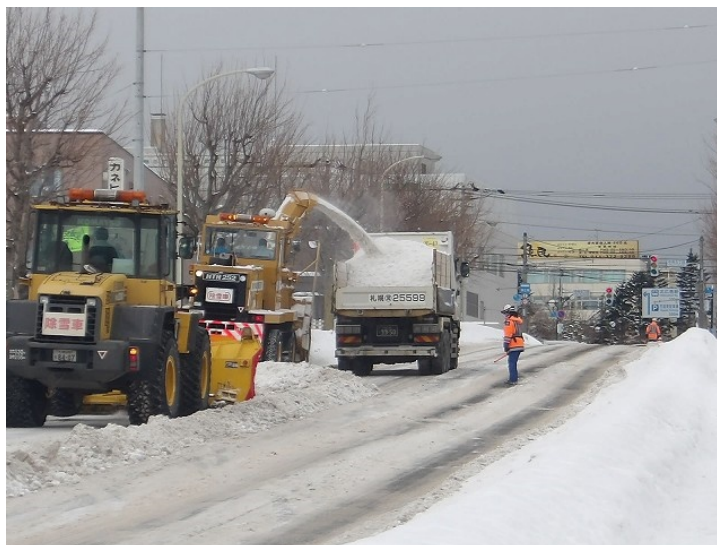
市道排雪状況
