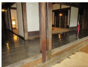
写真 5-7-2 改築による2本の柱
