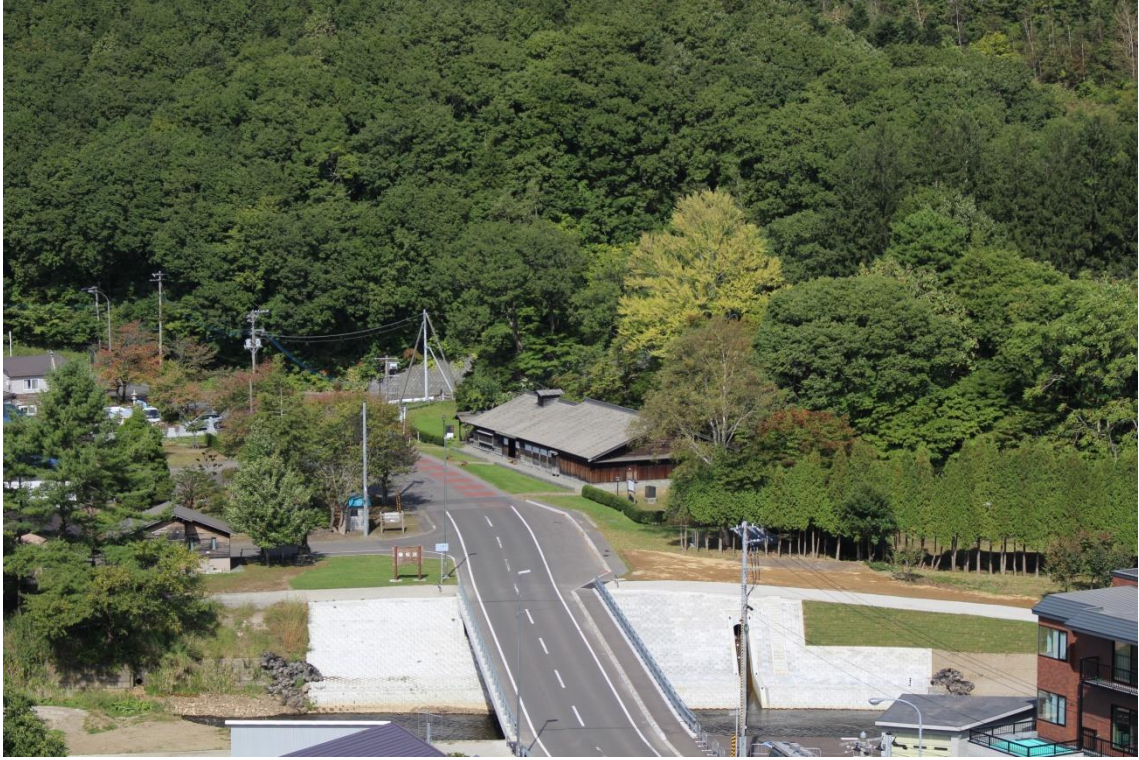
旧島松駅通所全景
