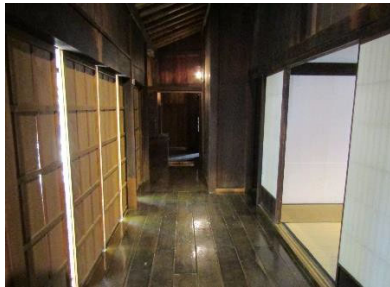
写真 2-2-11 座敷外周部の廊下
