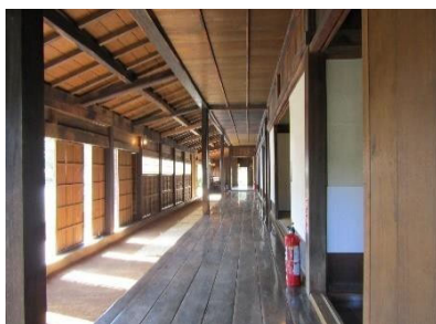
写真 2-2-14 西側「土縁」(道路側)
