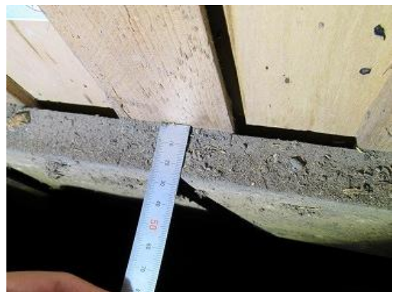
【写真 2-8 内部壁貫材幅寸法】
