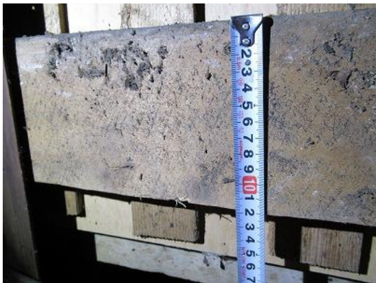
【写真 2-7 内部壁貫材高さ寸法】
