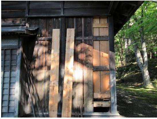
【写真 2-1 外部壁下地】
