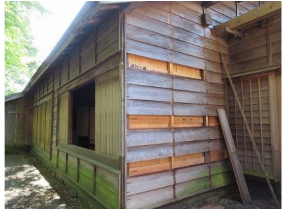
【写真 2-2 外部壁下地】
