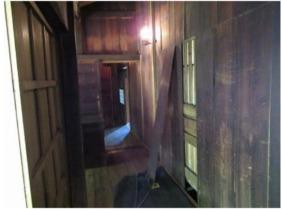
【写真 2-6 内部壁下地】
