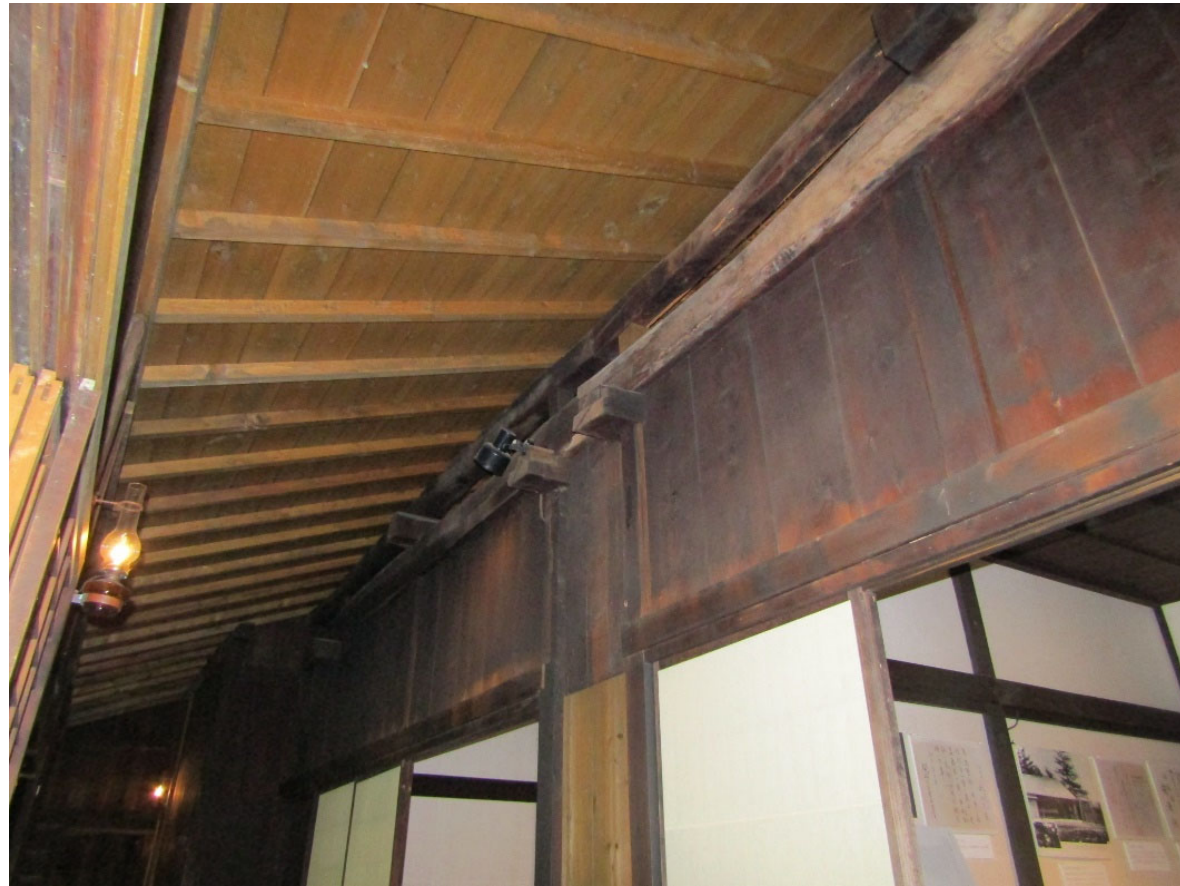
廊下3（山側の廊下）現況写真
