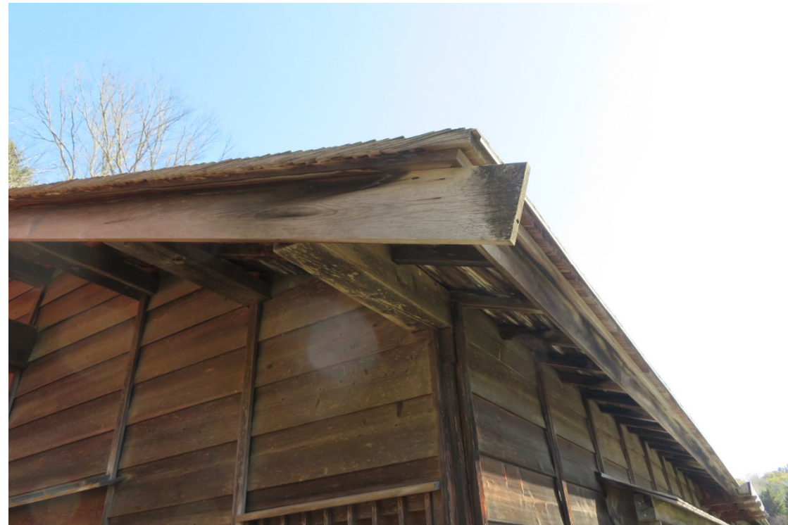
写真1 旧島松駅通所 屋根軒先部分
