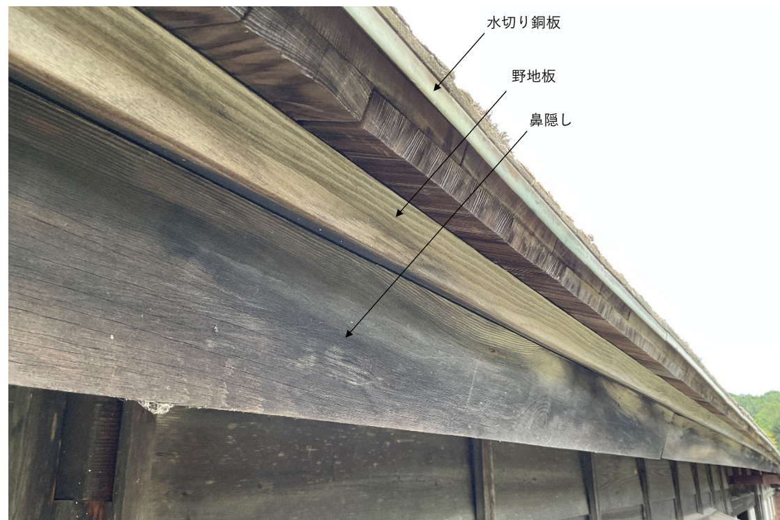
写真2 旧島松駅通所 屋根軒先部分
