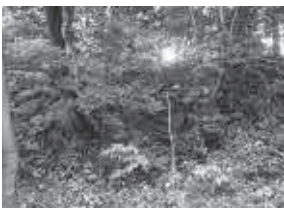
急傾斜地崩壊危険箇所 (市内中央5丁目)
