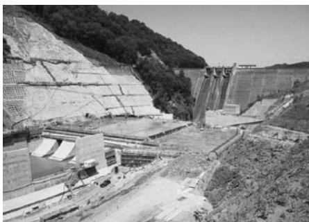
建設工事中のシューパロダム
