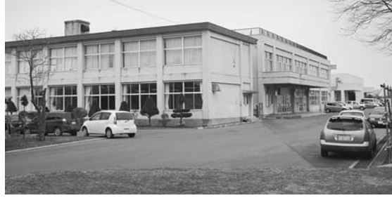
21年度の増築工事を終え地震補強工事が予定されている西の里中
