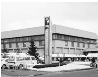
大規模改修される総合体育館
