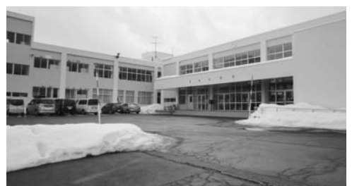
統合により誕生した緑ヶ丘小学校
