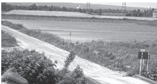
造成中の遊水地
