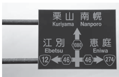
点検を行う大型標識
