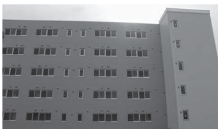
市営住宅共栄団地
