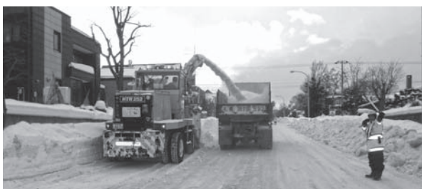
排雪作業中の大型ロータリー車
