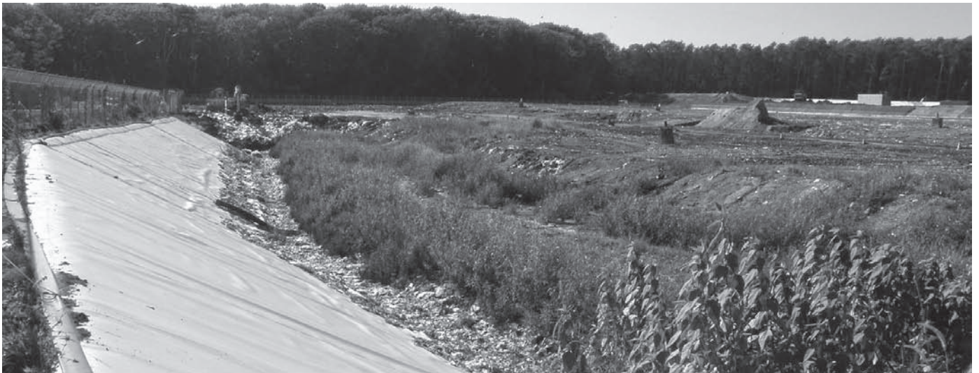
第5期最終処分場（平成26年10月現在の様子）
