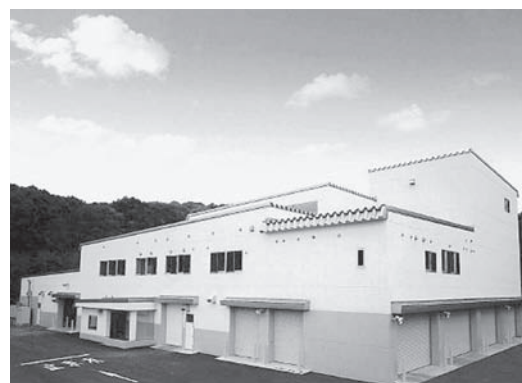
粗大ゴミ等が直接搬入できるクリーンセンター
