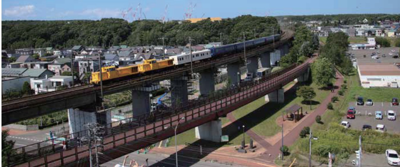
市役所5階展望テラスから北海道ボールパークFビレッジの建設地を望む
