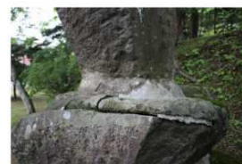
軟石劣化状況
