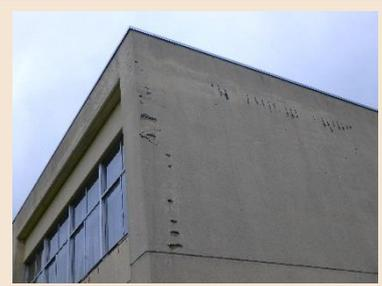
外壁の鉄筋露出
