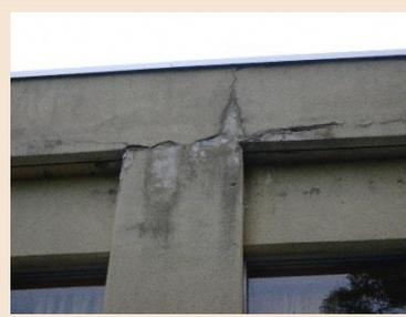
外壁仕上げモルタル剥落
