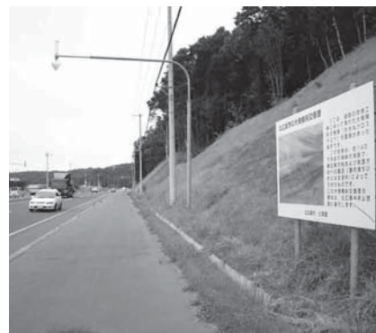
拡幅工事が終了した現在の道道栗山・北広島線。右手斜面の芝の下に、大規模斜交層理が眠っている
