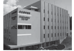
新庁舎の建設
