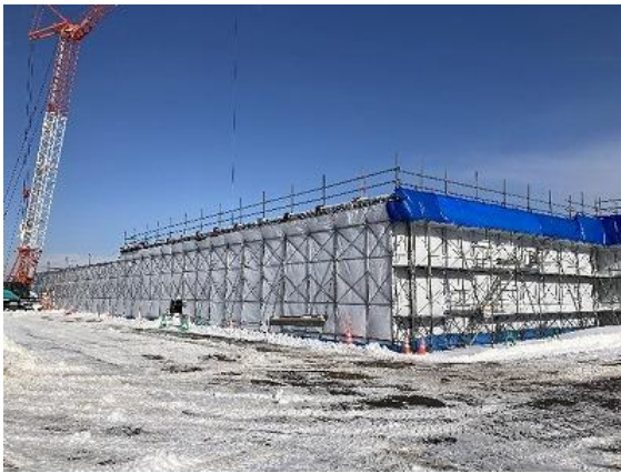
現在の施工状況（外観写真）
