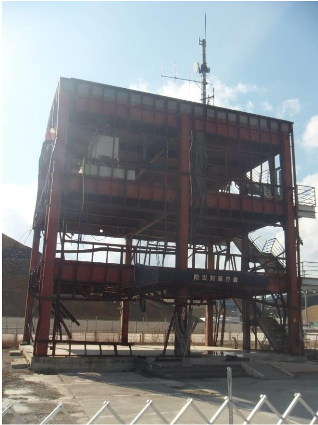
←南三陸町の防災対策庁舎
