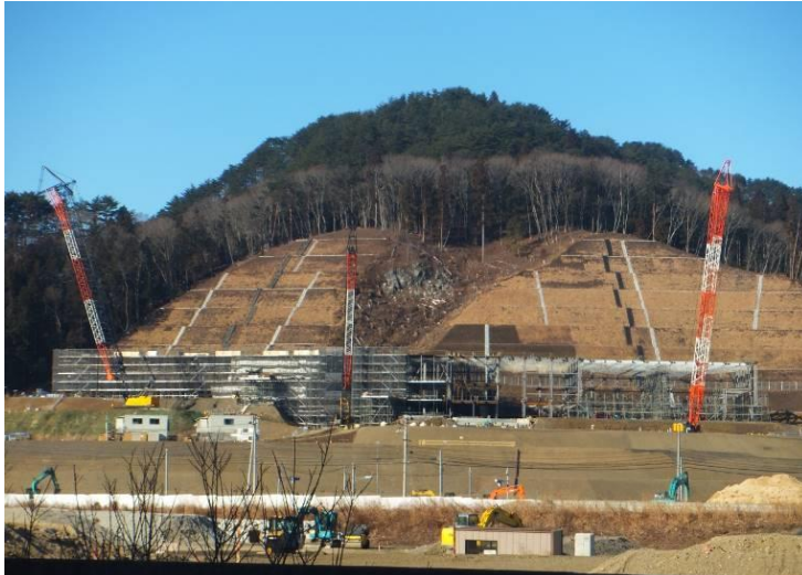
←鶺住居地区の高台に新しく建設中の小・中学校の校舎
