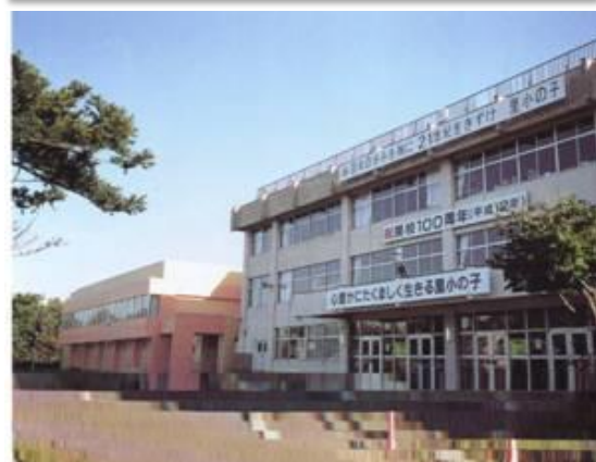
新体育館工事完工（平成11年）
