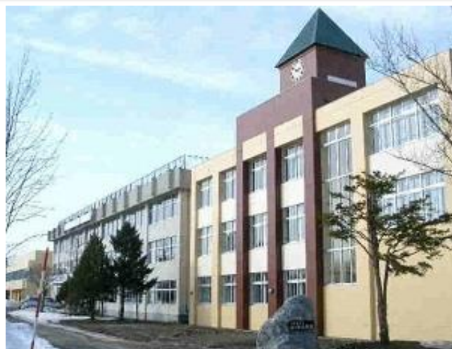
待望の特別教室増築完了（平成19年3月）
