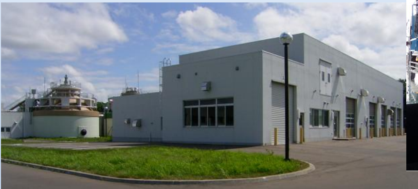
バイオマス混合調整棟
