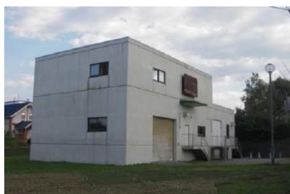
大曲ポンプ場
