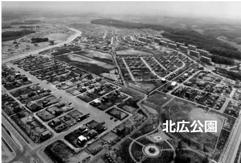
造成直後の北広島団地
