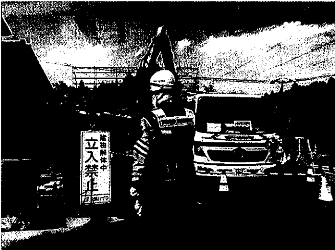
家屋の解体工事。廃材はこの地区からの搬出禁止。
